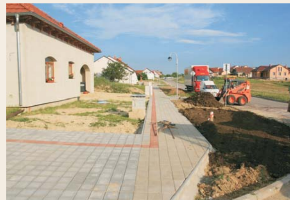
Úprava odvodňovacího příkopu
